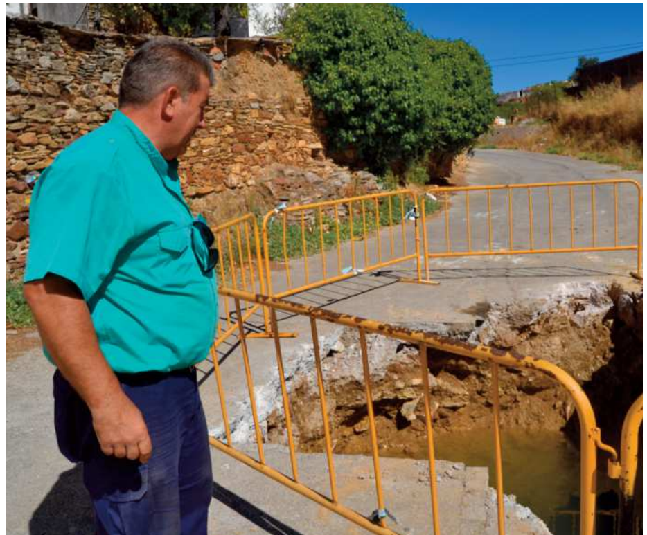
Luis González visita una de las averías de agua
